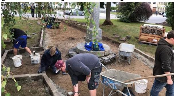
Nach dem Mittagessen wurde mit dem Schleifen und Lackieren der Handpumpe beim Wasserbrunnen begonnen. Weiters starteten die Burschen mit dem Setzen der Pflastersteine rund um den Pranger, sowie dem Ausfüllen der Ritzen mit Beton. Eine weitere Gruppe errichtete im Firmengebäude von der Dachdeckerei Honeder die „Hollywood Schaukel“.
